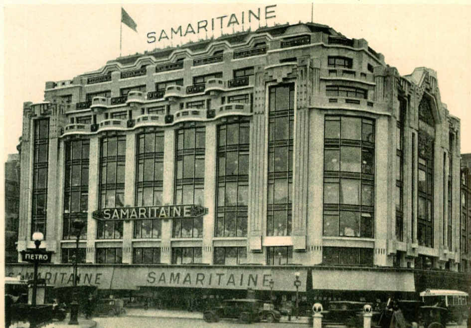
Fig. 26. — Magasin de Nouveautés à Paris. (Communiqué par les Ateliers de constructions SCHWARTZ-HAUTMONT.) Architecte : M. Henri SAUVAGE.
