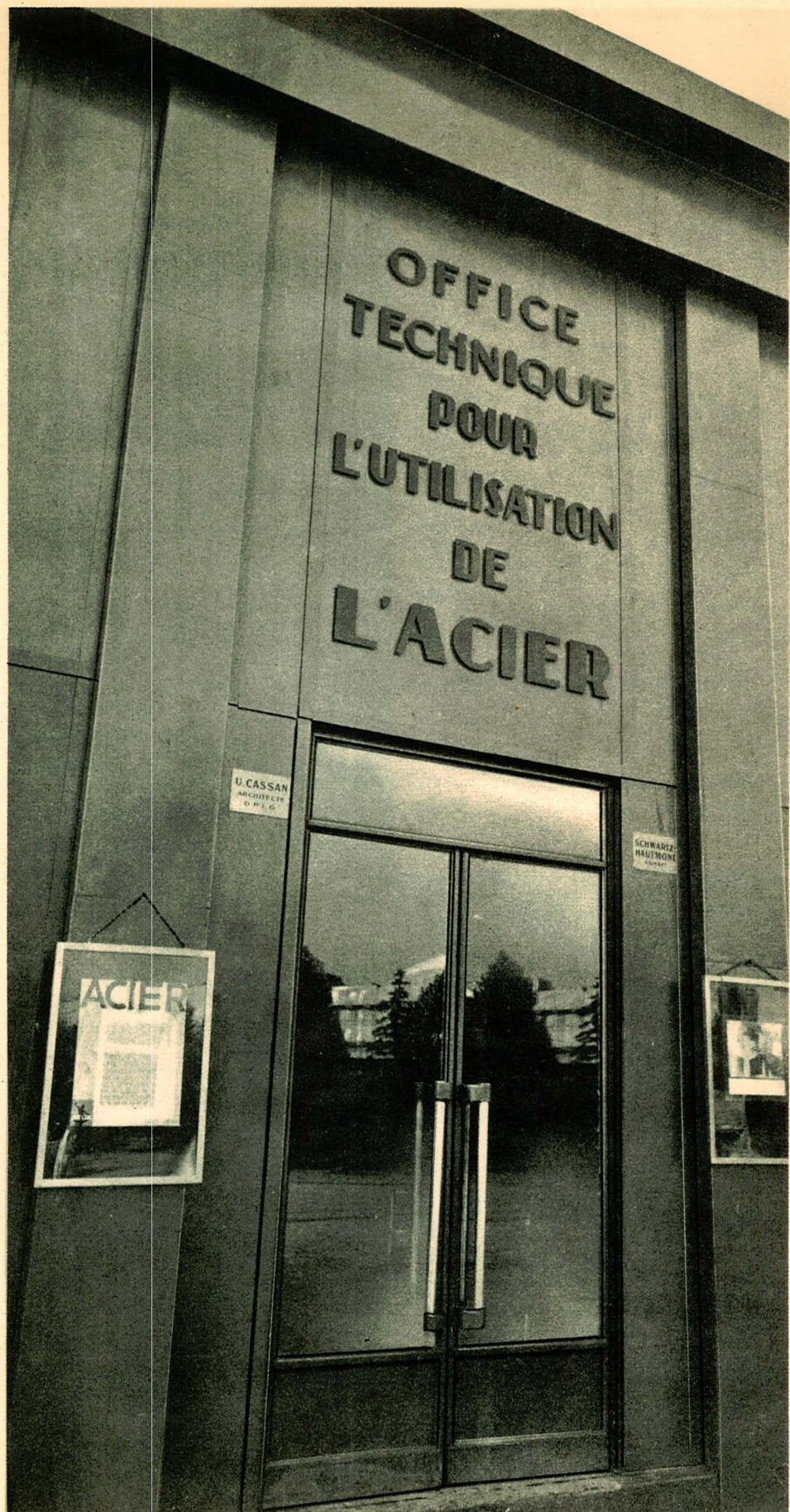
Fig. 33. — Porte d'un pavillon d'Exposition de l'Office Technique pour l'Utilisation de l'Acier. (Communiqué par les Ateliers de constructions SCHWARTZ-HAUTMONT.) Architecte : M. U. CASSAN.
