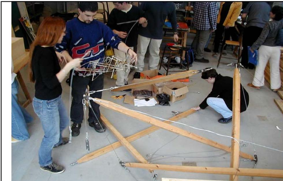
*T.D. de Morphologie à l'Ecole d'Architecture de Nantes. Montage d'une structure avec barres en bois de 2mètres de longueur, à partir d'un modèle d'étude à barres extensibles en aluminium / laiton, (réseau double-nappe sphérique).*
