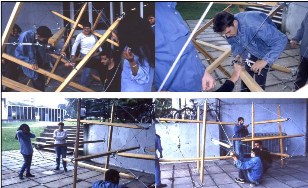
*Assemblage de 2 mailles du réseau « icoso orthogonal ». Laboratoire de Morphologie de l'E.N.S.A.N., 1992.*
