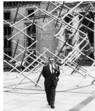
**Principe de montage du modèle ci-dessus exposé à Varsovie, fabriqué à l'E.A. Paris-la Villette, et monté sans échelle ni palan (environ 6m. de hauteur).**
