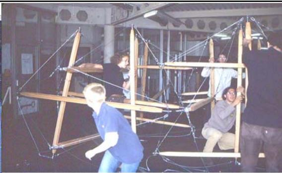
*Assemblage de 4 mailles du réseau « icsa orthogonal », soit 4 icosaèdres (24 barres).*
