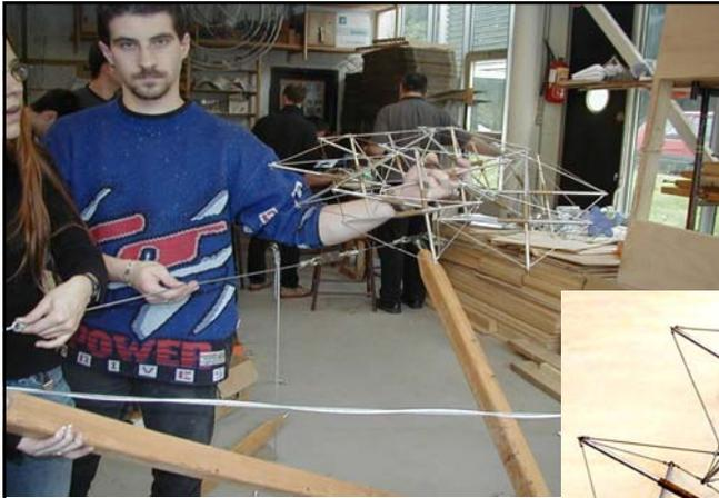
*T.D. de Morphologie à l'Ecole d'Architecture de Nantes. Montage d'une structure avec barres en bois de 2mètres de longueur, à partir d'un modèle d'étude à barres extensibles en aluminium / laiton.*
