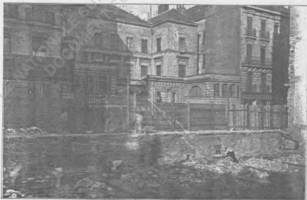
chantier la nationale sur Lafayette
