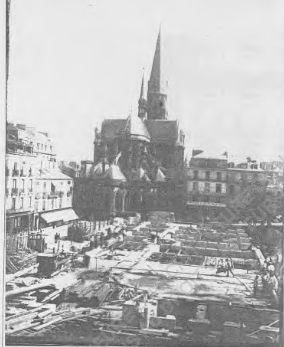
chantier du marché de Joffe
